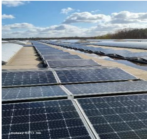
Windkraftanlage und Sonnenkollektoren auf dem Dach von Fingo Tessenderlo
